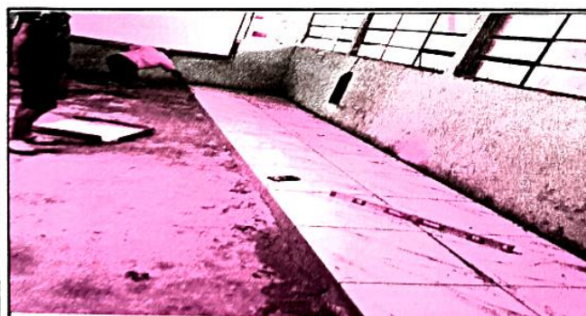
Se observa durante el inicio del pegado ceramico dentro del aula
