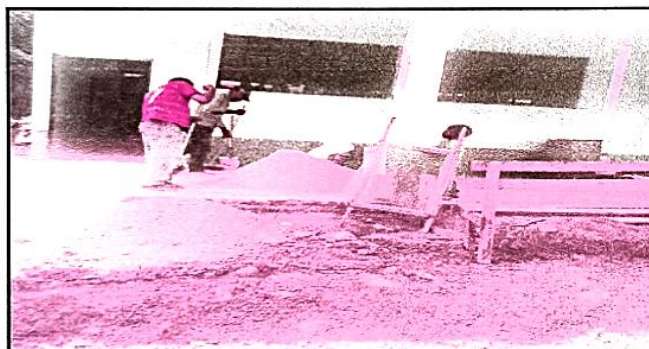
Se observa la mezcla del pegamix del ceramico del centro educativo
